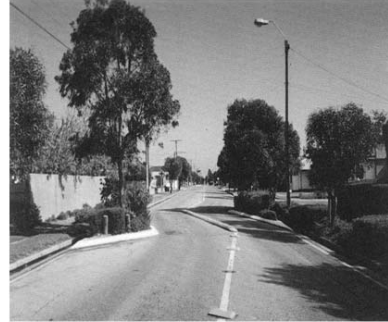
จุดชะลอความเร็วแบบทำมุม 2 ช่องจราจร ที่มา : Hawlay et al, 1993
