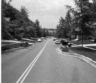
จุดชะลอความเร็ว 2 ช่องจราจร ที่มา : Ewing, 1999
