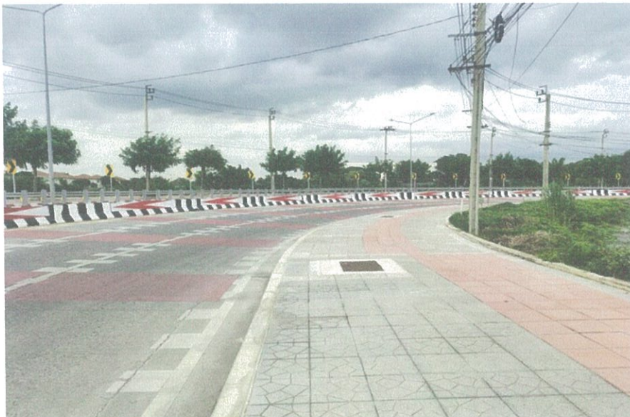
ภาพที่ ๕ การติดตั้งอุปกรณ์เตือนทางโค้งอันตรายถนนราษฎร์อุทิศ ซอย ๑ เขตมีนบุรี กรุงเทพมหานคร
