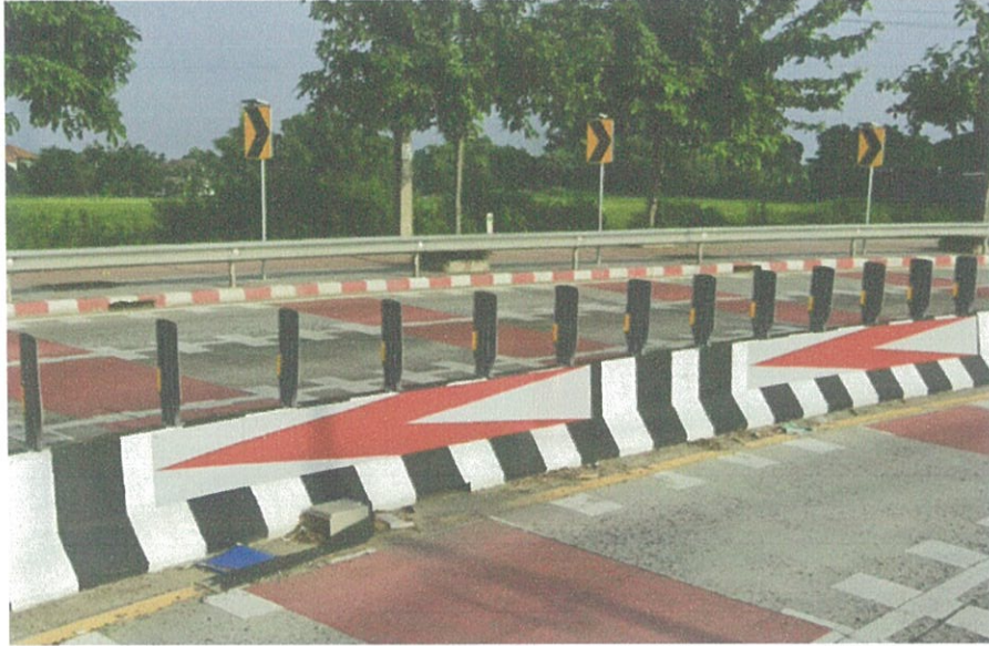
ภาพที่ ๕ การติดตั้งอุปกรณ์เตือนทางโค้งอันตรายถนนราษฎร์อุทิศ ซอย ๑ เขตมีนบุรี กรุงเทพมหานคร
