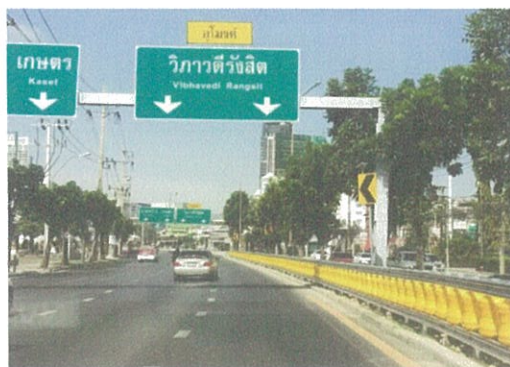
ภาพ : แสดงตัวอย่างลูกกึ่งกันอันตรายลดความรุนแรงของอุบัติเหตุ (SAFETY ROLLER BARRIER)
